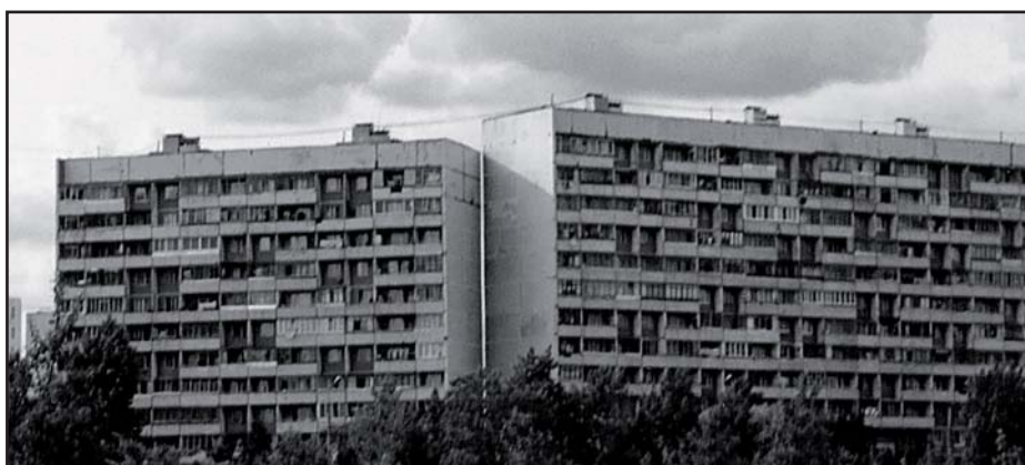
Рис. 3.2.3.5. Крупнопанельные жилые дома с наружными стенами из трёхслойных панелей.
