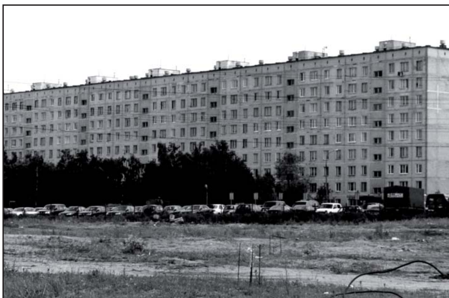
Рис. 3.2.3.4. Крупнопанельные жилые дома с наружными стенами из однослойных керамзитобетонных панелей (ранние серии до 9-ти этажей).
