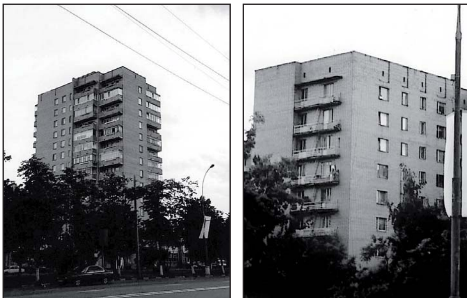
Рис. 3.2.1.1. Кирпичные дома со стенами сплошной кладки.
